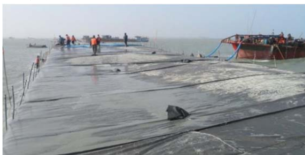
图 3 船型大砂袋围堰建成图
