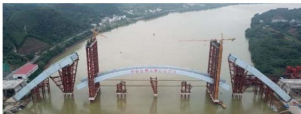
图 1 中段拱肋整体提升前
