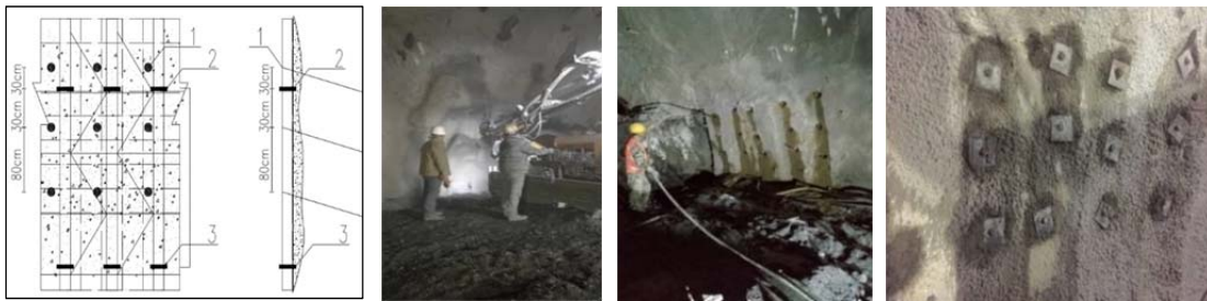
图 2：边墙变形集中部位长锚杆主动约束
