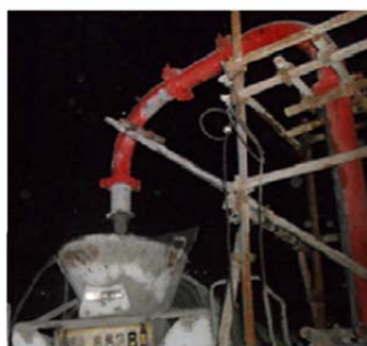
图4 混凝土流入搅拌车内
