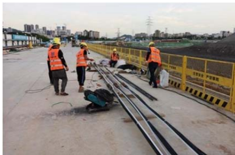
图 3 锚杆杆体现场制作加工
