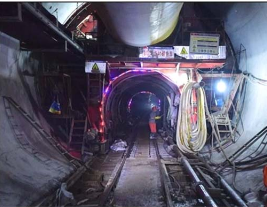
图 3 同步衬砌施工
