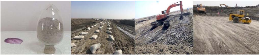
固化材料及施工现场
