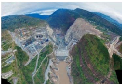
图1 白鹤滩水电站围堰实景
