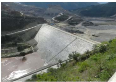
图2 白鹤滩水电站围堰实景
