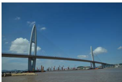
大榭二桥钢塔
