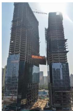
图 1 腾讯滨海大厦连廊提升
