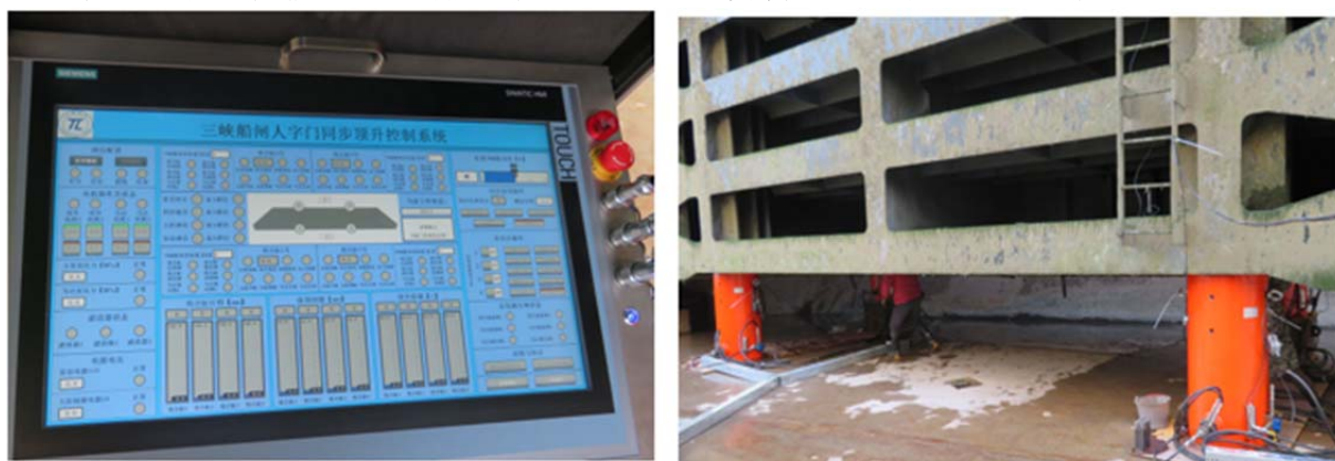
图 1：人字门液压顶升现场实施图
