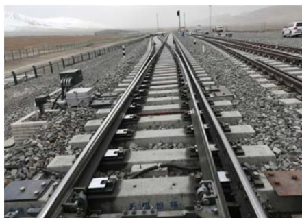
楔形调整弹片式扣件在线路的应用
