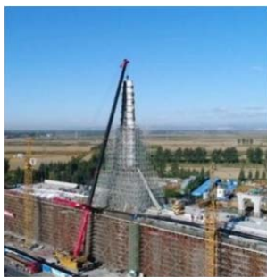
图 1 索塔节段就位施工
