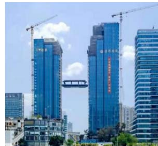
华邦国际中心连廊提升
