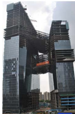
图 2 腾讯滨海大厦连廊提升
