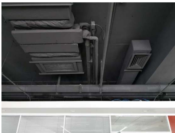
图 5 苹果园交通枢纽 J 地块中国铁建耀中心室内新风口
