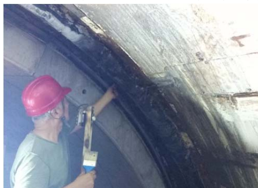
图3 施工中对气囊气密情况进行检查
