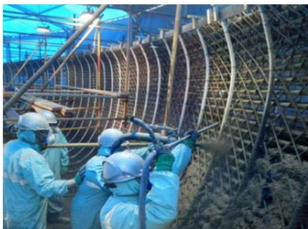
图1 赛道混凝土喷射施工
