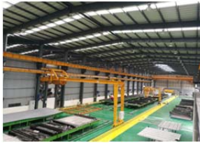
图1 构件一厂生产线建设示例
