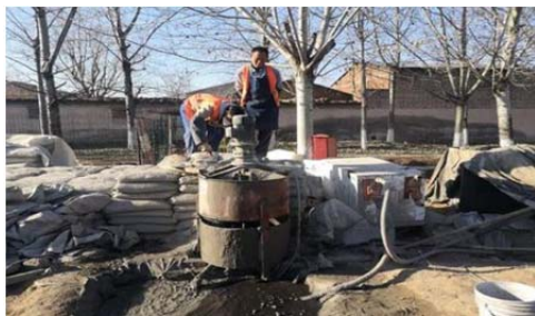
图1 触变泥浆制备
