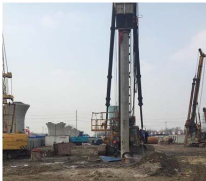
图 1 跟钻法工艺沉桩
