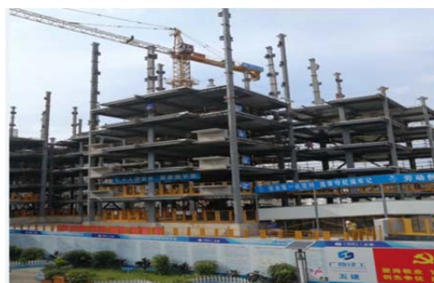
图2 装配式钢结构住宅体系现场照片
