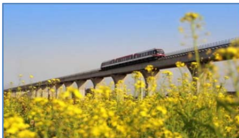
长沙磁浮线实景图
