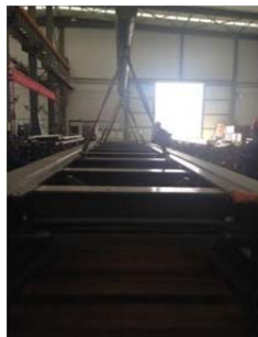
(e) 单榀轨排吊装
