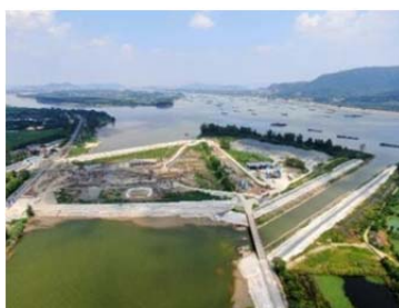
图3 富阳北支江围堰实景
