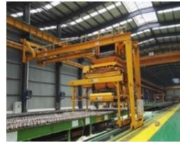
图3 混凝土运、布料设备无线智能对接
