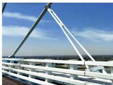
(5) LMD-V (沪苏通长江大桥-1092m, 最长索长 577m)
