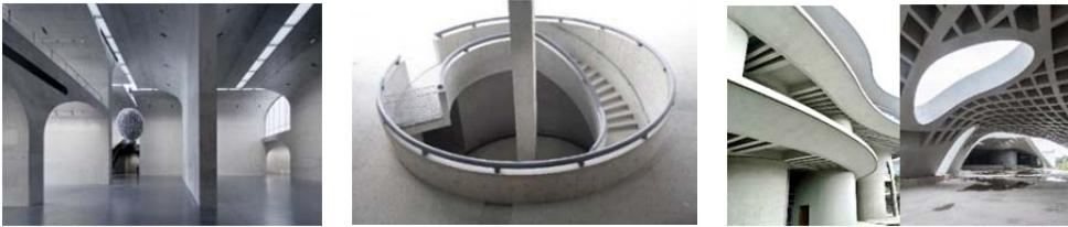
图1 复杂异形清水混凝土结构
