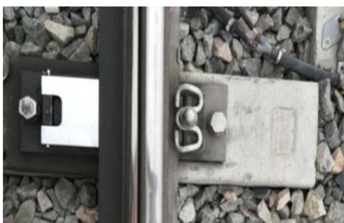
楔形调整弹片式扣件实物
